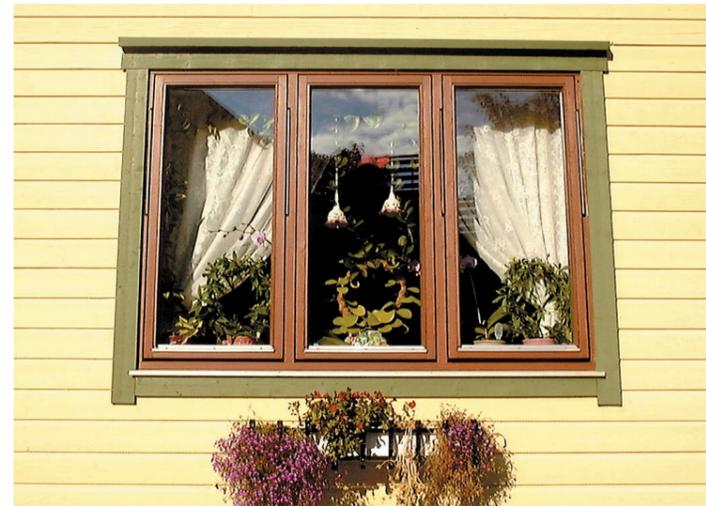
建物の開口部である窓は外観のデザインを決めるポイントであり、室内側からは景色を眺める等、感覚的にも重要な役割をはたしています。又、建物の品質を大きく左右する気密性や断熱、遮音性といった性能のほか、採光や換気、さらには緊急時の脱出口等さまざまな機能を要求されます。木製アスナロサッシ「森の窓」は、能登の豊かな風土の中で育てられた天然のヒバ[能登アスナロ]や北欧パイン材、透明な特殊金属膜をコーティングした高断熱複層ガラス[LOW-Eガラス]、そして確かな品質のドイツや北欧製の金属パーツを使用して、あくまでも窓の基本性能を高めるために本物の品質にこだわり、物づくりのクオリティを追求して創られた木の窓です。
